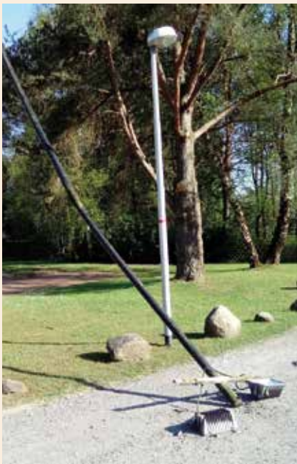
Bild vom abgeknickten Flutlichtmast. Foto Holger Meyer
