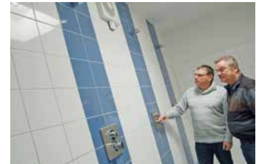
Ortsvorsteher Holger Heier und 1. Vorsitzende Holger Meyer begutachten die neuen Duschräume.
