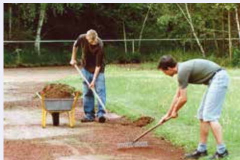
Auch die Laufbahn muss vorbereitet werden.
